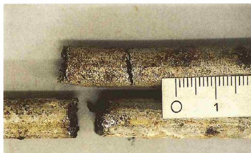
Abbildung 1.1: Befestigungsbügel der abgehängten Decke des Hallenbades Uster nach Spannungsrisskorrosion und anschließendem Sprödebruch [Fal00].
